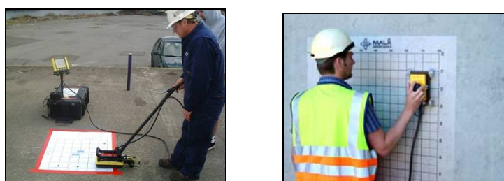
Fig. 11 - Ensaios de betão armado com radar
