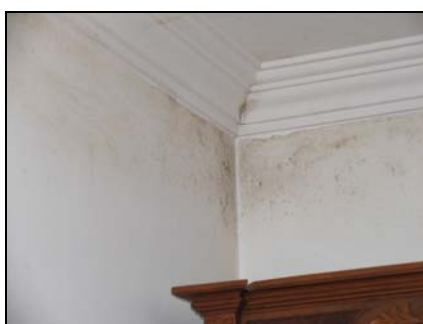
Fig. 5 - Condensação superficial
