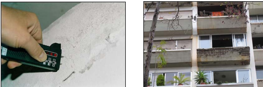
Fig. 1 - A inspeção periódica pode evitar estados de degradação avançada dos edifícios
